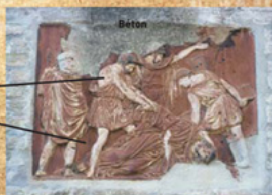
Une des plaques de Lorgues avant restauration Les peintures du 20 ème siècle recouvrent tout
