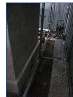
Fig. 3 - Vue du rez-de-chaussée de l'échafaudage © Amélie Méthivier
