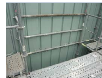
Fig. 4 et 5 - Vues montrant des planchers manquants, sans garde-corps © Amélie Méthivier
