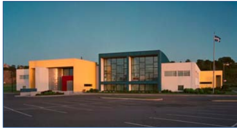
Fig. 1 - Façade du Centre de conservation du Québec © Bernard Vallée, Fonds des moyens de communication du Québec
