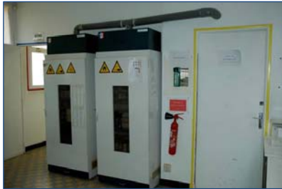
Fig. 3 – Les anciennes armoires à produits, non étanches et mal ventilées n'assuraient pas de protection en cas d'incendie © Jacques Rebière
