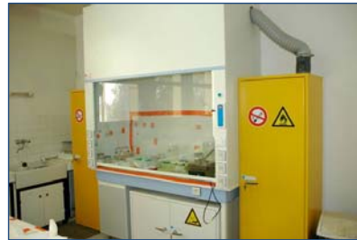
Fig. 2 – La sorbonne actuelle est équipée d'armoires à solvants. Son ouverture est verticale et elle est pourvue d'une aspiration continue (silencieuse) et variable selon l'amplitude d'ouverture de la porte © Jacques Rebière
