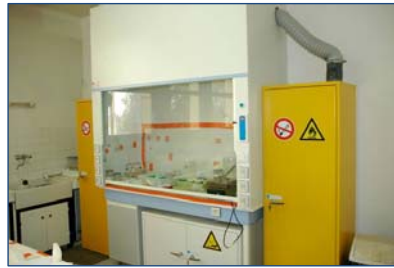
Fig. 2 – La sorbonne actuelle équipée d'armoires à solvants. Son ouverture est verticale et elle est pourvue d'une aspiration continue (silencieuse) et variable selon l'amplitude d'ouverture de la porte © Jacques Rebière
