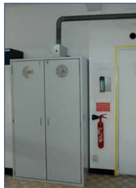
Fig. 4 – L'armoire actuelle est étanche, offre une protection coupe-feu de 90 minutes avec une aspiration continue et dépourvue de « coudes » de tuyauterie. Les anciennes armoires serviront à entreposer de petits appareils et n'ont plus de fonction liée à la chimie © Jacques Rebière
